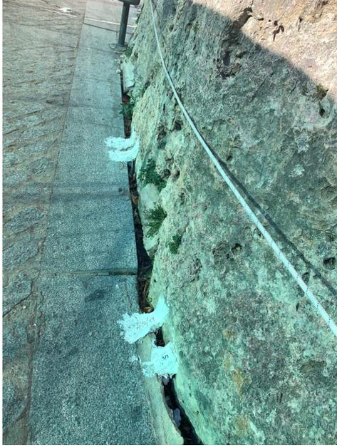
Esta separación se manifiesta en una grieta a lo largo de todo el contacto carretera/pared de roca, de unos centímetros de ancho y que durante los meses de septiembre y octubre de 2019 se sigue ensanchando como demuestra la fisuración de los testigos de yeso que el ayuntamiento ha colocado.
